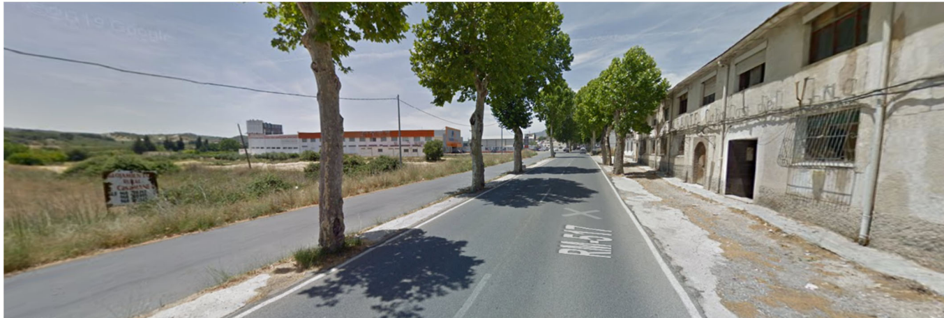
Figura 77. Perspectiva visual actual de la avenida sobre la que se situaría el carril bici. Fuente: Google Maps.
