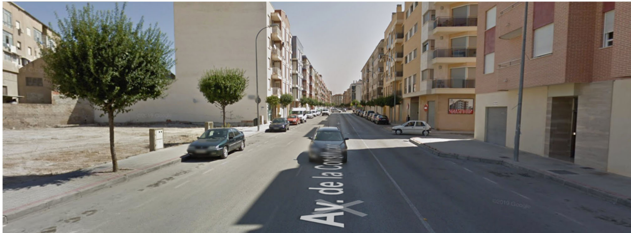
Figura 71. Perspectiva visual actual de la avenida sobre la que se situaría el carril bici. Fuente: Google Maps.
