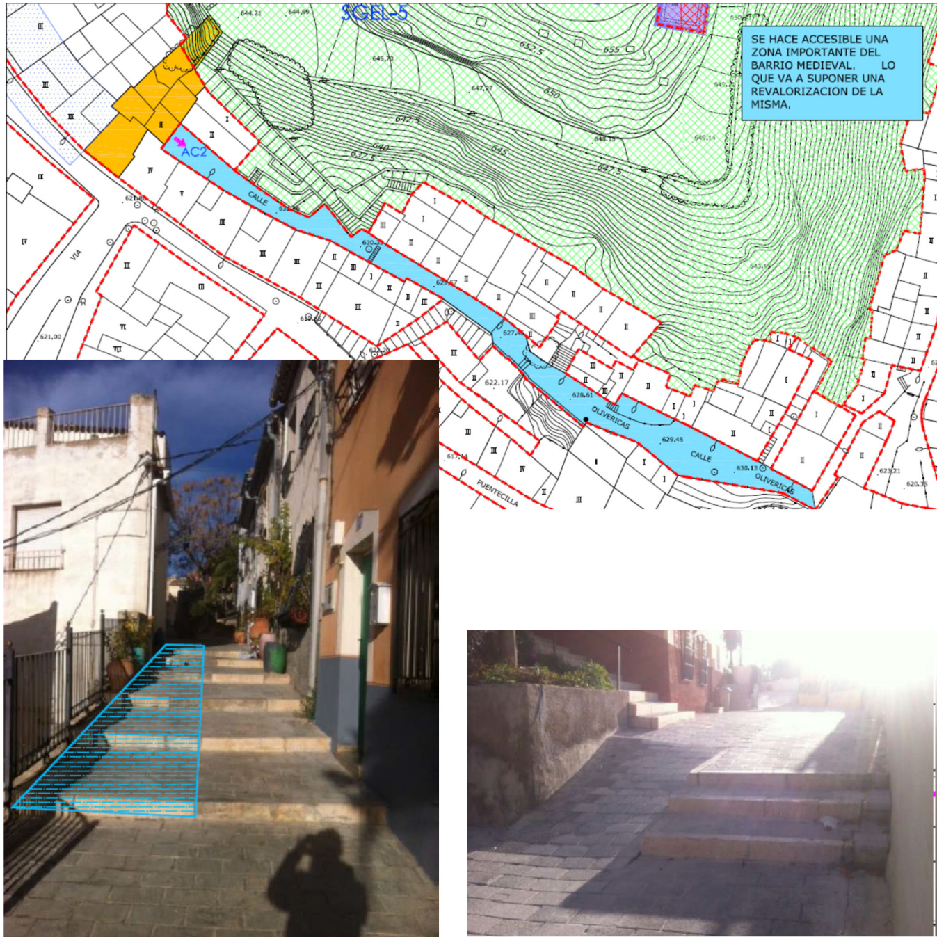
Figura 150. Inserción de rampas intermedias en zonas con desniveles para facilitar la accesibilidad a personas discapacitadas.
