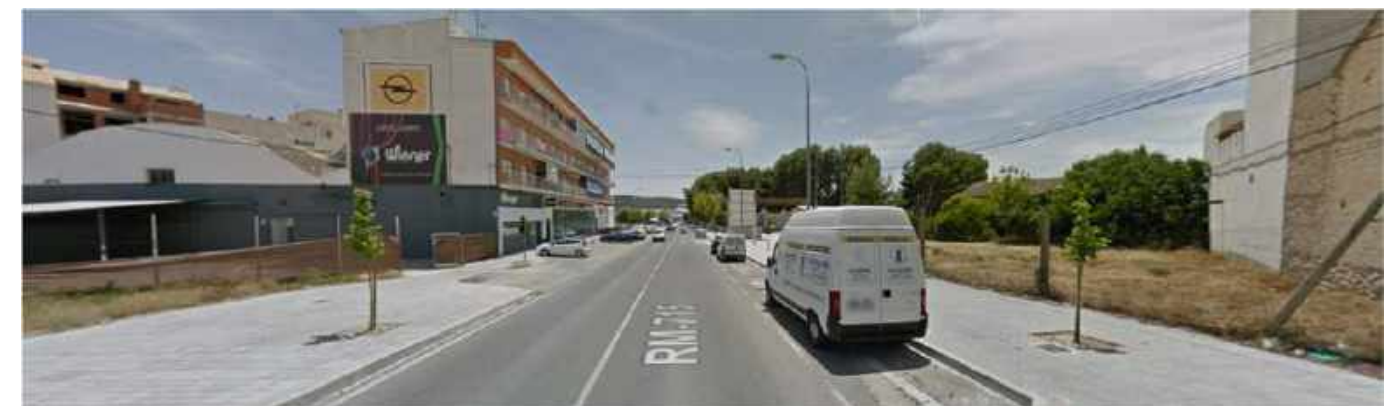
Figura 83. Perspectiva visual actual de la avenida sobre la que se situaría el carril bici. Fuente: Google Maps.
