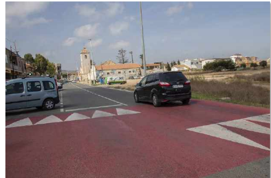
Figura 151. Ejemplo de resaltos de lomo y almohada señalizados con pintura en color en las interurbanas.
