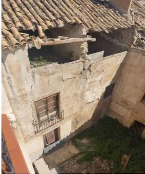
Fotos 2 a 5: En las dos superiores se aprecian los paños de cubierta a ambos patios interiores con derrumbes parciales y peligro de nuevos derrumbes. En las dos inferiores son del patio interior de este inmueble y en ellas se aprecia la existencia de una puerta bajo el balcón que da a la estancia en galaberno de la C/ Vidrieras, nº 5.
