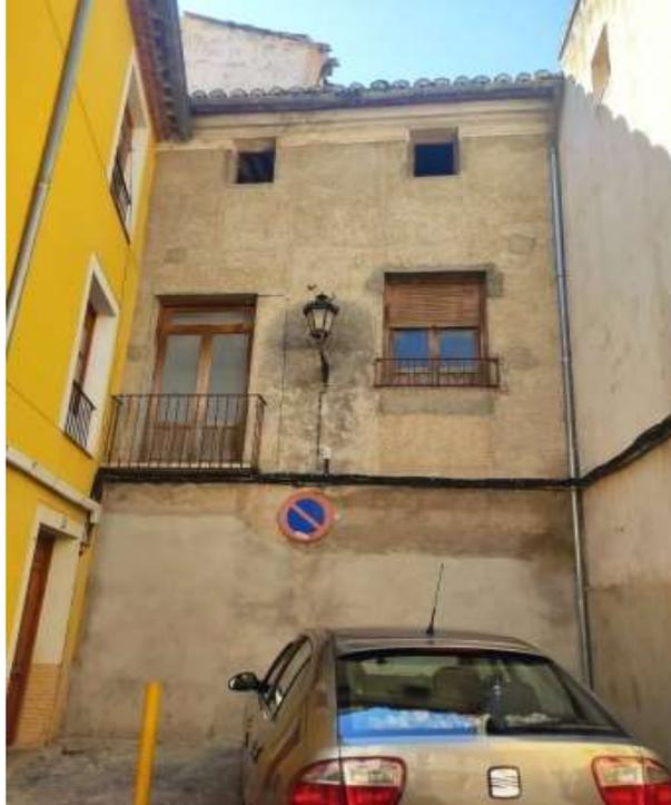
Foto 1: Fachada a C/ Nueva. Los huecos de planta baja han sido tapiados.
