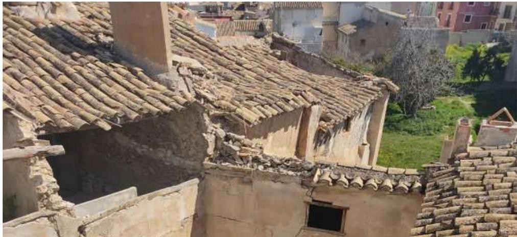
Foto 7: Al fondo a la derecha se aprecia el derrumbe parcial de cubierta, que según manifestación del vecino de la C/ Vidrieras, nº 5, se ha producido tras la nevada de enero de 2021, así como de la importante flecha que presentan los paños de cubierta que han quedado en pie.
