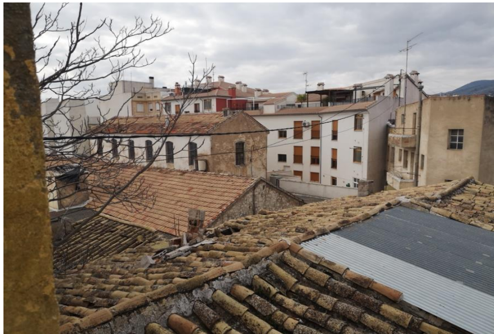
Parte de la cubierta hundida.
