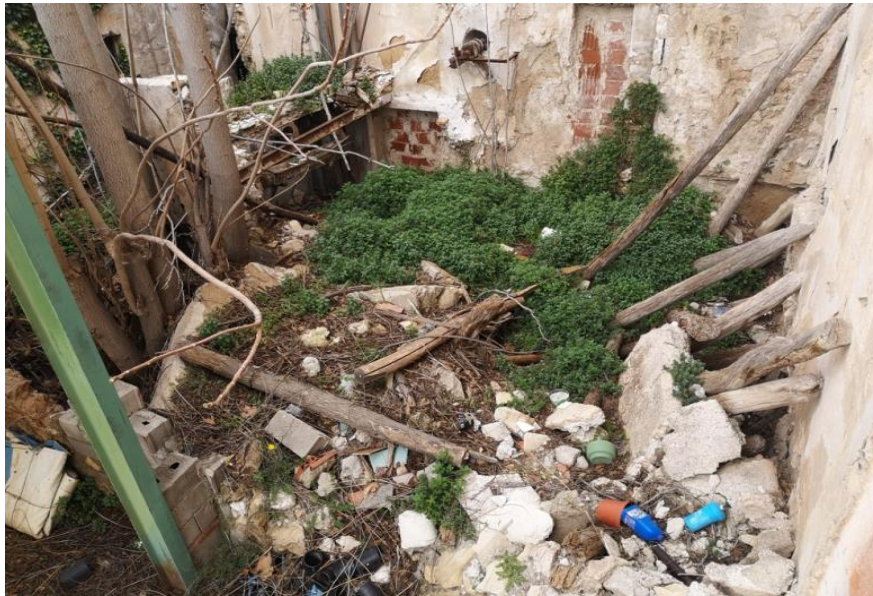
Estado de la fachada posterior recayente
