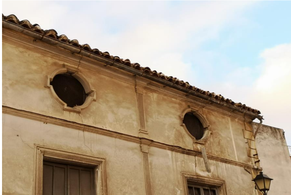
Estado de alero y cornisa con tejas sueltas con peligro de caída a la vía pública.
