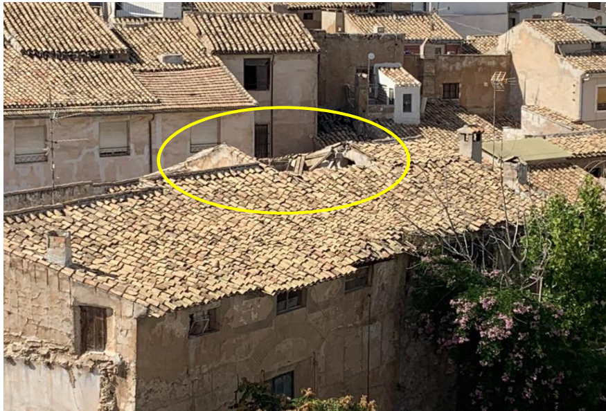
Parte de la cubierta hundida.
