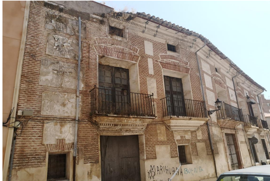
Estado de la fachada principal.
