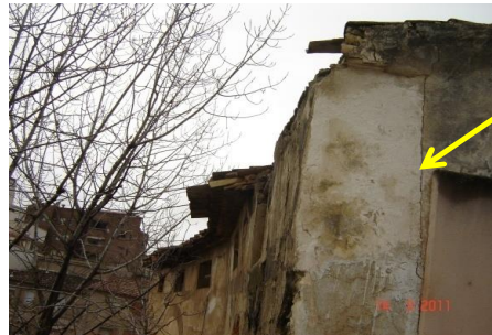
Estado grieta en 2011.
