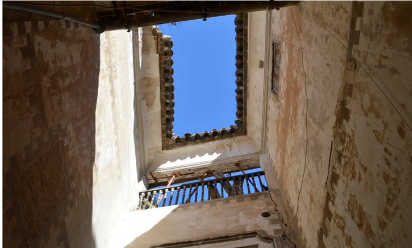
Estado del patio interior
