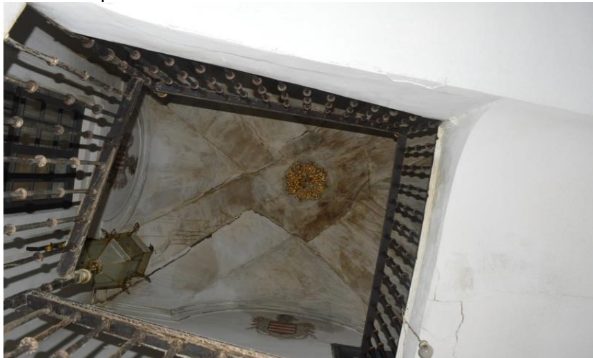
Estado de la bóveda de la escalera.
