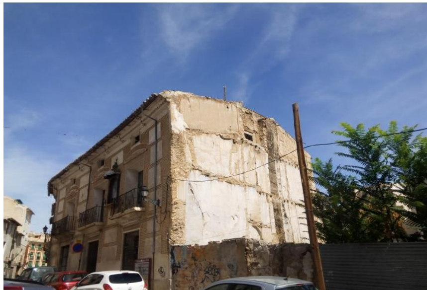
Estado de la medianera sur.
