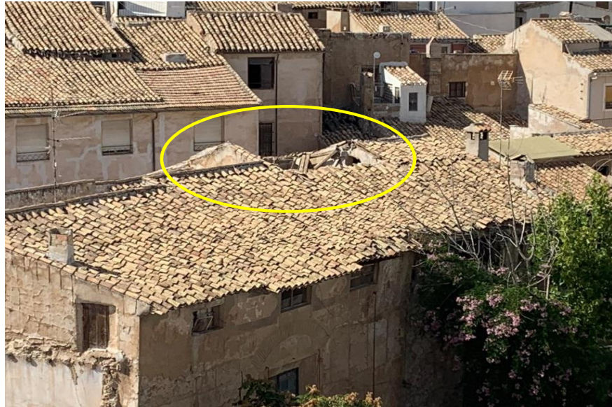
Parte de la cubierta hundida.
