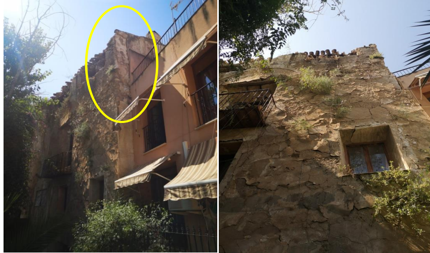
Estado de la fachada posterior recayente al jardín.
