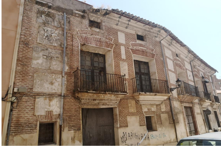
Estado de la fachada principal.
