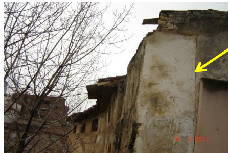
Estado grieta en 2011.
