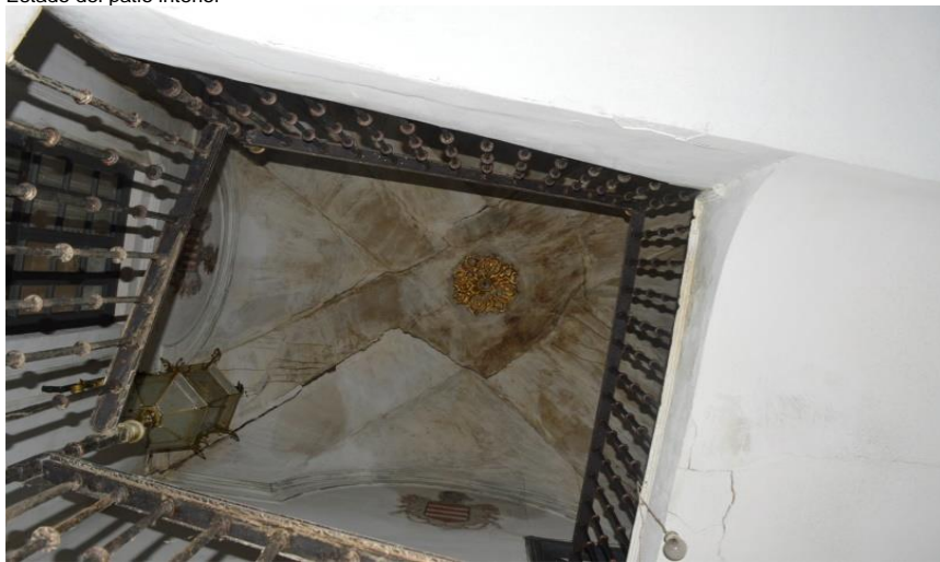
Estado de la bóveda de la escalera.
