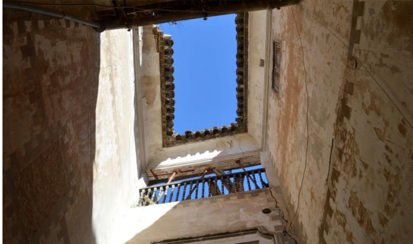
Estado del patio interior
