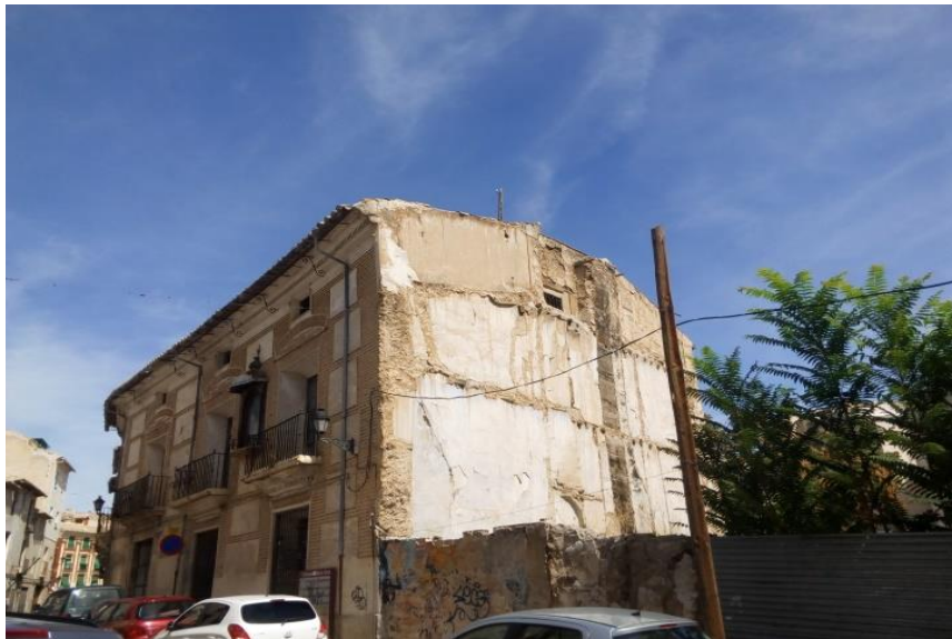
Estado de la medianera sur.
