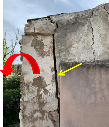
Estado grieta en 2019.
